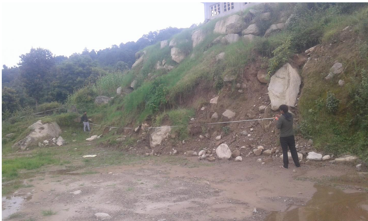
DRR Project team doing technical survey of Gokulganga Secondary School Mitigation Site- Rasnalu - ( गोकुलगंगा माध्यामीक विद्यालय रस्नाल्को पहिरो जोखिम अल्पिकरण साइटमा प्राविधिक सर्भे गर्दै परियोजनाका कर्मचारीहरु )
